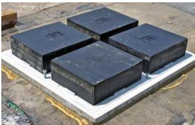
Bild 3. Auflagerpunkt mit 4 Elastomerlagern
