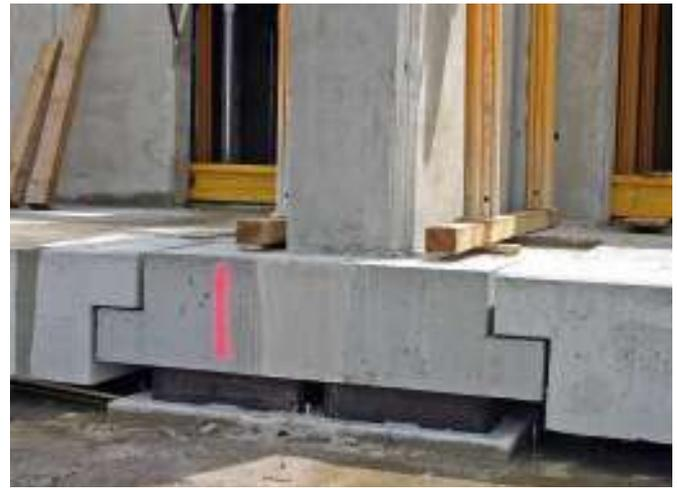
Bild 7. Lagersockel mit Elastomer-Einzellager zur Lastweiterleitung in das Tiefbauwerk
